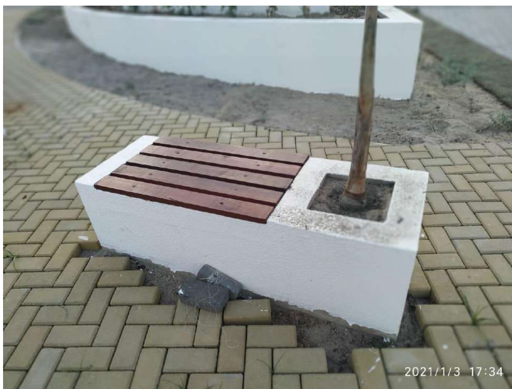
Figura 01 – Falta de acabamento do piso intertravado
